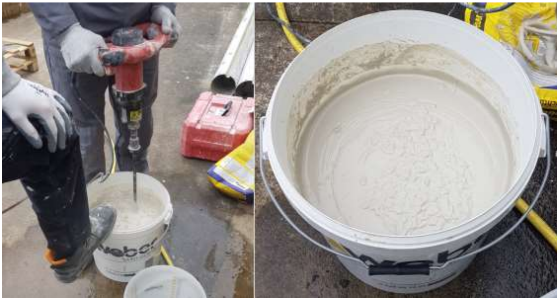
Abbildung 60: Dichtmasse mischen
