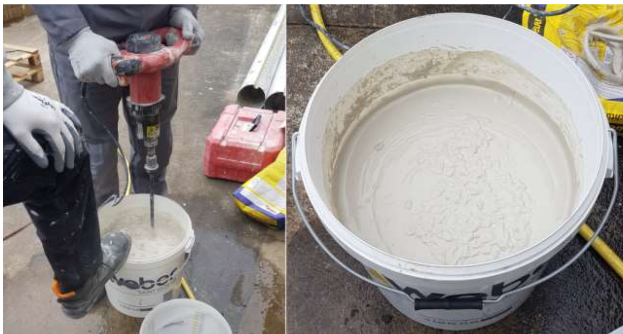
Figure 12 : Mélange d'enduit d'étanchéité
