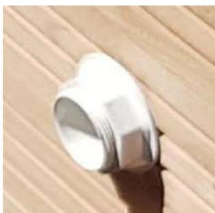
Visser la buse sur le bois à l'aide de l'écrou en pvc
