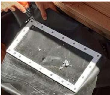
Visser les vis du contour du skimmer dans le skimmer en traversant la bâche et les 2 joints
