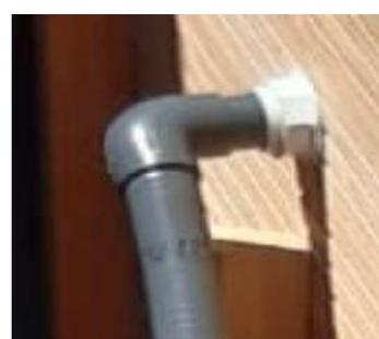
Coller tuyau diamètre 50 souple dans le coude à 90°
