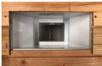
Fixer le skimmer sur la structure en bois à l'aide de 4 vis 5x80, en traversant le bois et le skimmer de part en part
