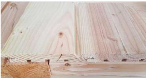
La lame suivante couvre la vis de fixation
