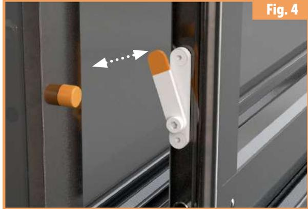
Il faut monter l'arrêt sur le module suivant de manière à ce qu'il soit **au même niveau que la partie marquée du « loquet »** et **au milieu du profilé de l'abri**. Veillez à maintenir la symétrie des modules de l'abri de part et d'autre.
