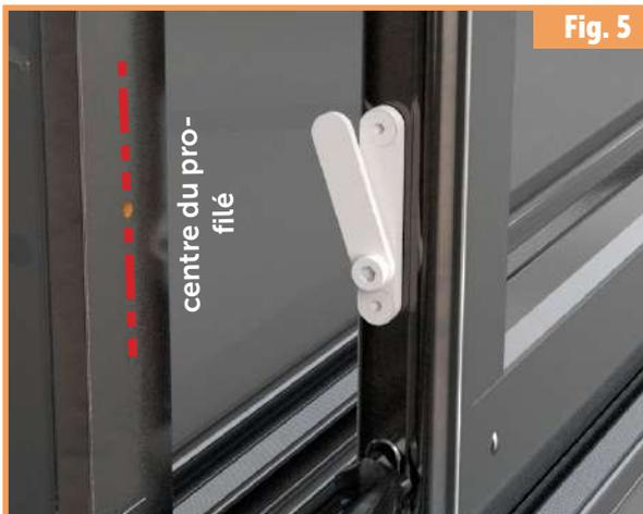
Marquez la position et pré-percez un trou de 3,5 mm diamètre. Puis, percez un trou de 5,5 mm pour une profondeur de 25 mm.
