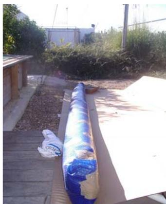
Centrer la couverture encore enroulée sur la largeur opposée au bloc ou découpe échelle si existant.
