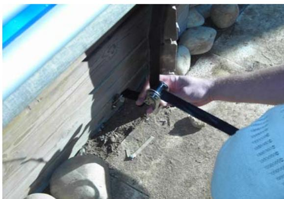
Coté bloc, tendre les cliquets de façon à mettre la couverture en butée sur le bloc.
