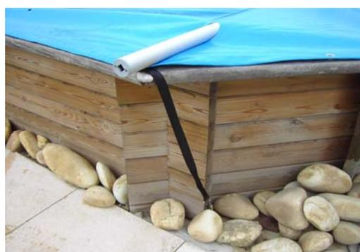
Positionner les crochets inox en face des œillets à 40 cm sous les margelles.
